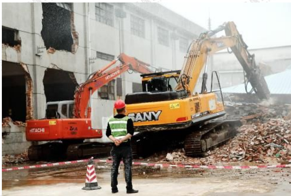
红岗片区施工现场
