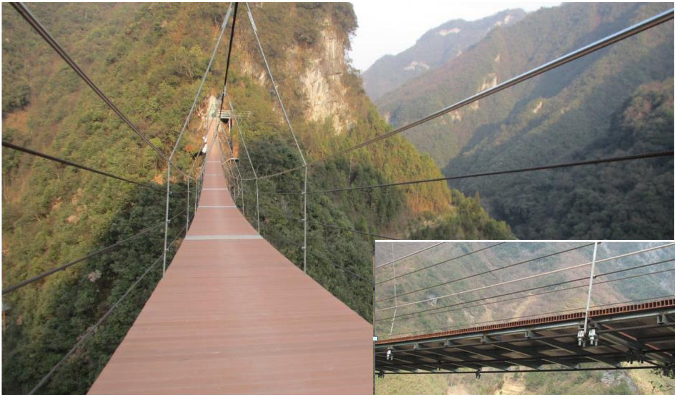
吊索桥“金刚木”栈道（跨距90cm）
