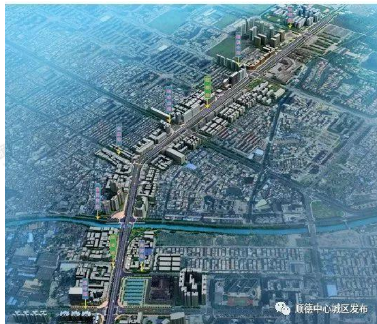
南国路改造工程
