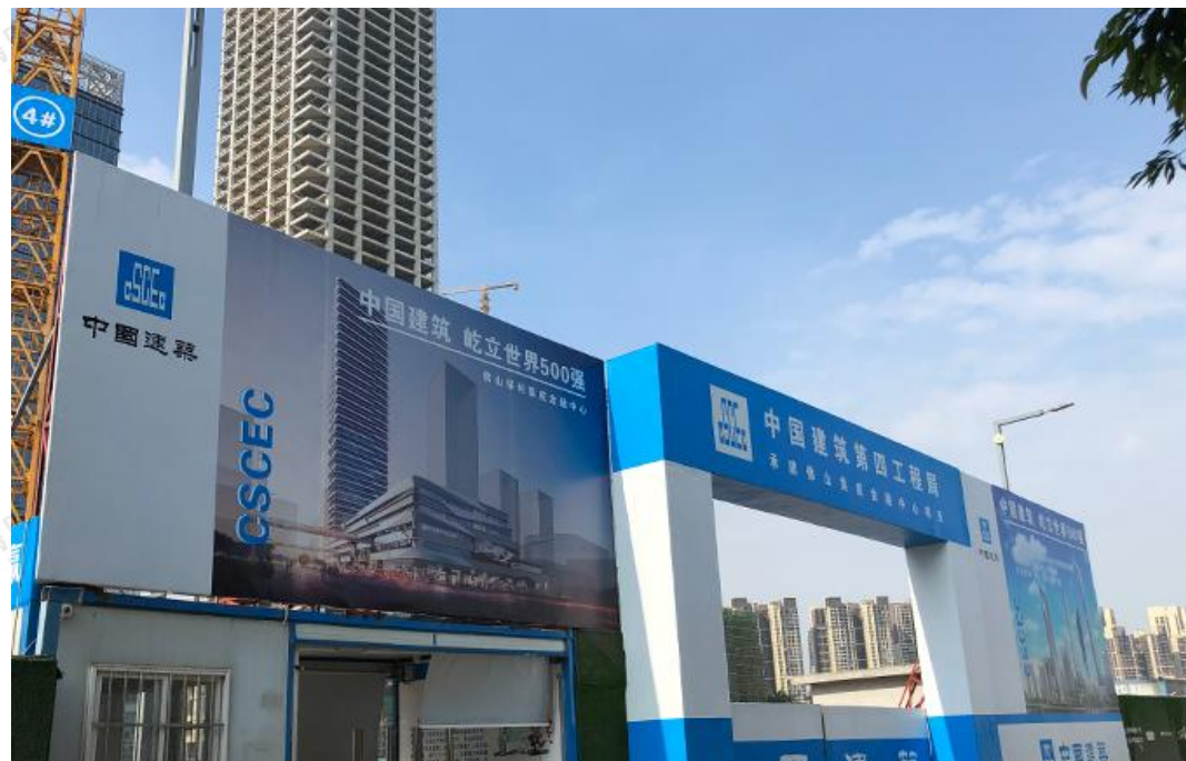
建筑施工外观
